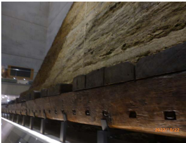
5. 堤の断面を切り取った物を移設
