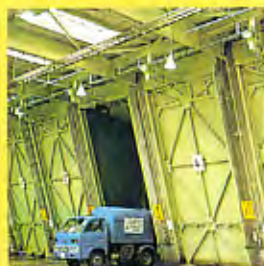
① プラットホーム
