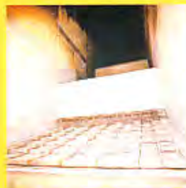
③ 焼却炉(内部)
