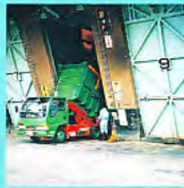
① プラットホーム
