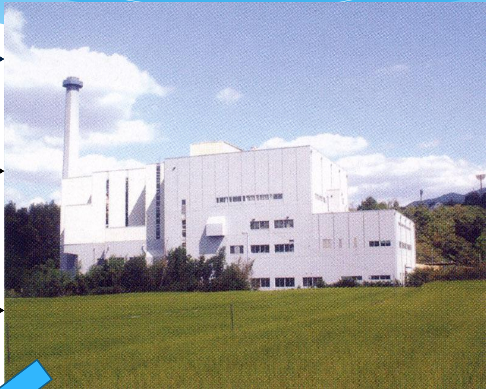
南河内環境事業組合第1清掃工場 富田林市甘南備
